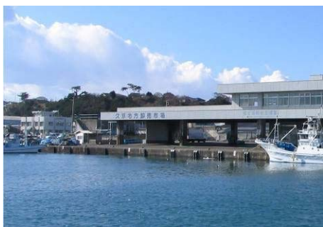
写真③ 久慈漁港状況
