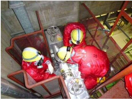
連絡配管閉止フランジ切替え訓練
