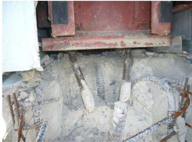
柱脚部コンクリート破壊
