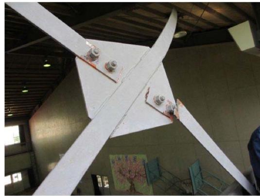
ブレース孔欠損部の破断
