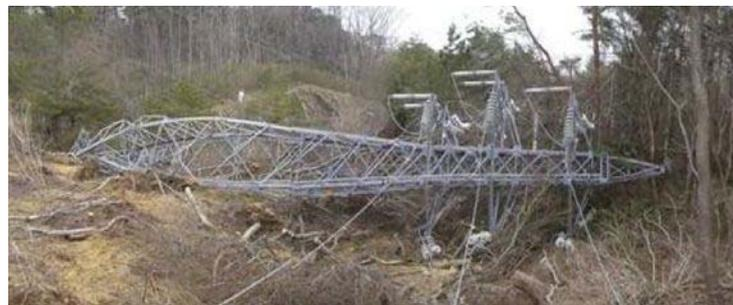
地震による斜面の崩落に伴う鉄塔の倒壊事例※2
