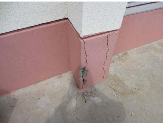
柱脚部コンクリートのひび割れ
