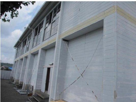
筋かい材の変形
