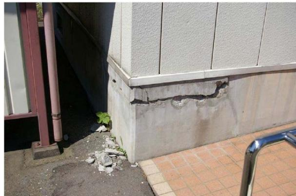
柱脚部コンクリートの割れ・剥落 (長岡市)
