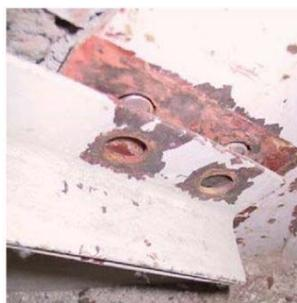
筋かい材ボルト破断
