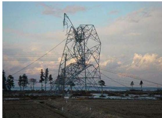
津波による隣接鉄塔の倒壊に伴う鉄塔の倒壊事例※2
