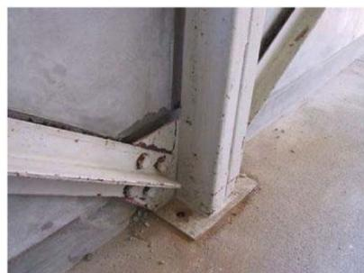
間柱脚部アンカーボルト破断
