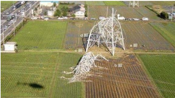
強風による鉄塔の倒壊事例①※1
