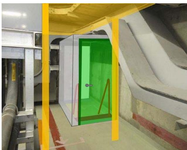
第1図 ケーブル処理室内階段室の設置イメージ
