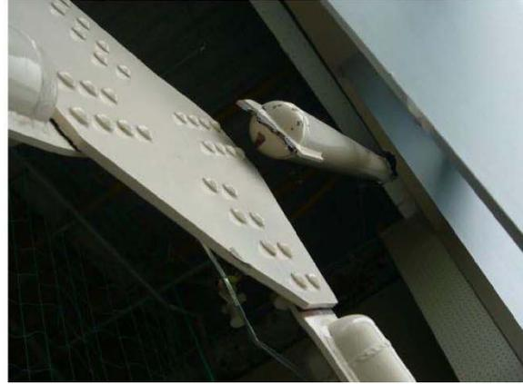
筋かい材プレート破断
