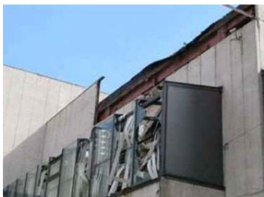
外装材の脱落，ガラス破損
