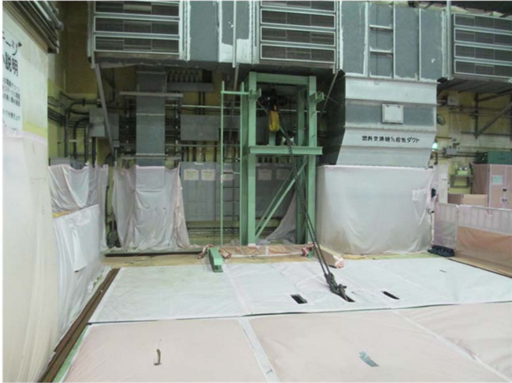
第1図 大物搬入口ハッチの閉状態
