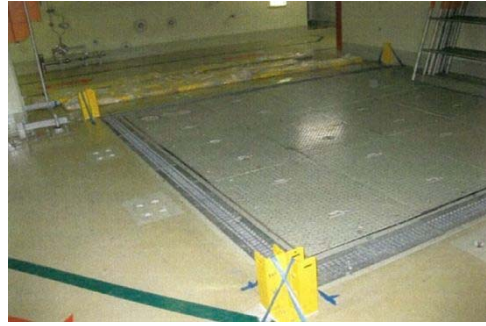
支柱レールの取付状況例
