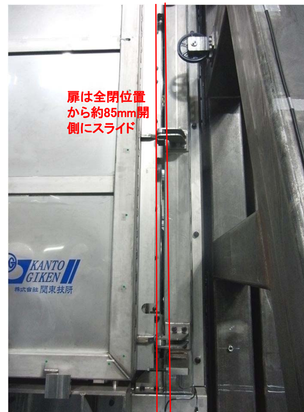
扉閉レベル4(1.1Ss)後の扉状態(6月21日)
