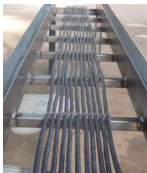
(シート施工前)
