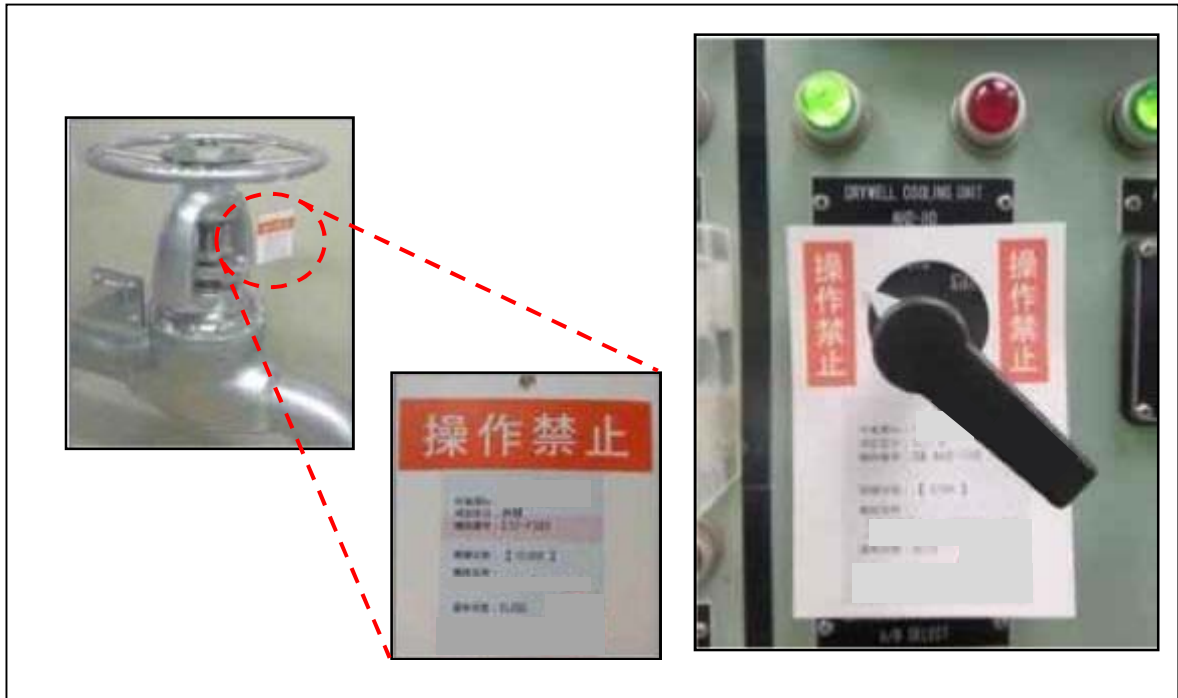
第 2.3-1 図 操作禁止札による識別（例）
