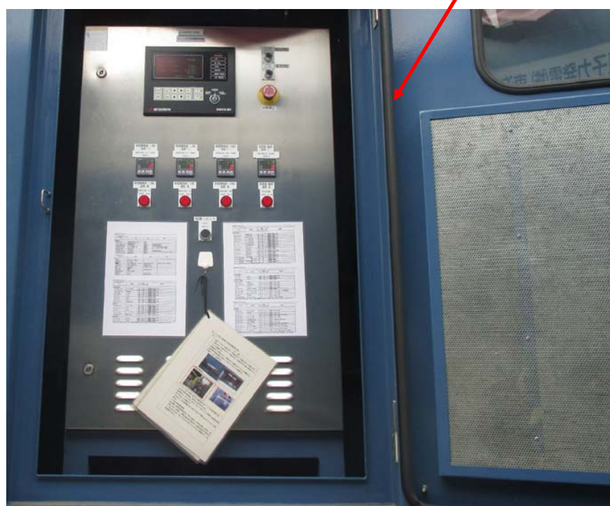
第 2 図 制御盤扉のパッキン施工
