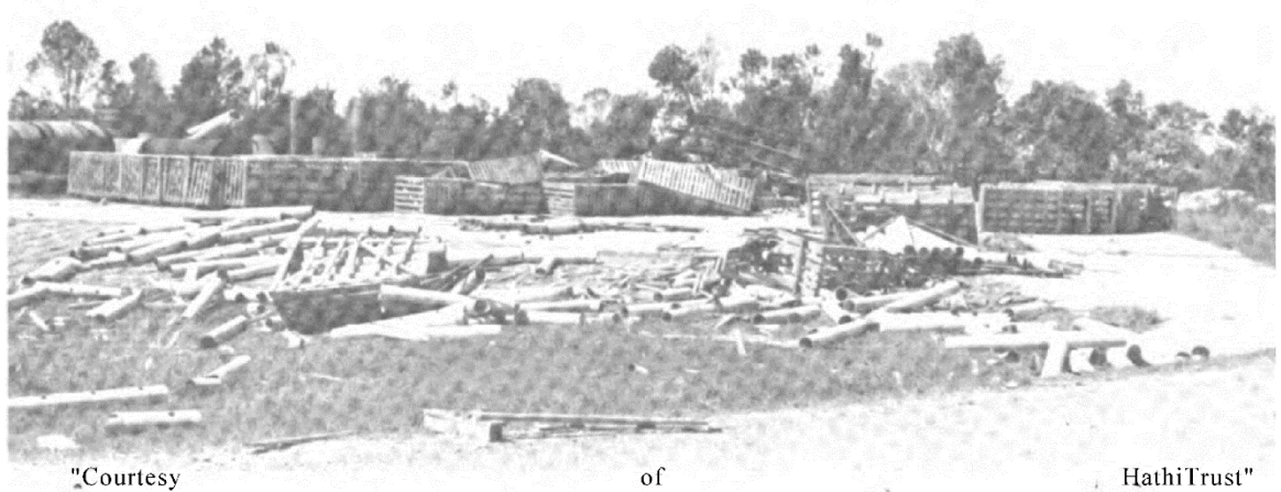
図5-1 Grand Gulf原子力発電所資材置き場におけるパイプの散乱状況 (10)
