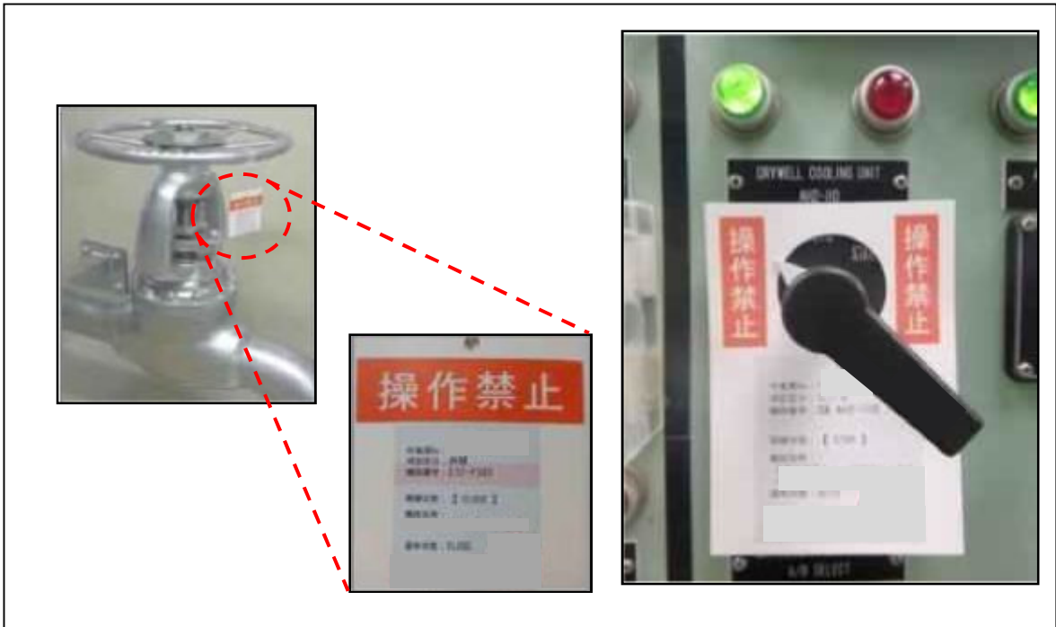
第 2.3-1 図 操作禁止札による識別（例）
