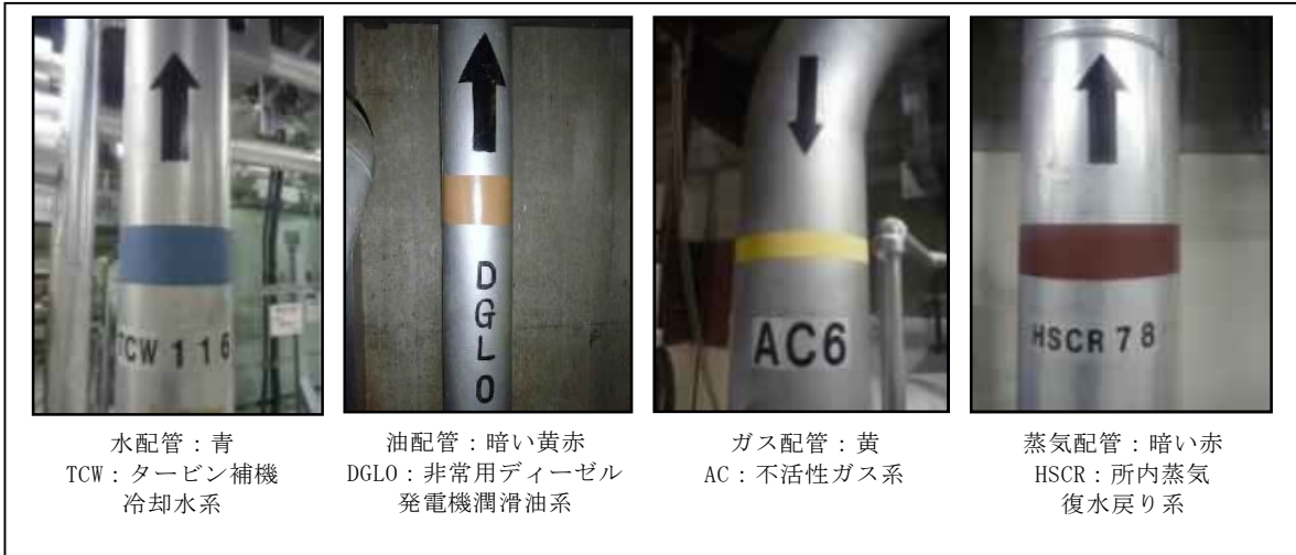
第 2.2-2 図 配管の識別管理（例）
