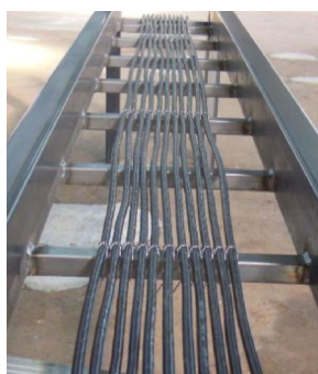
(シート施工前)
