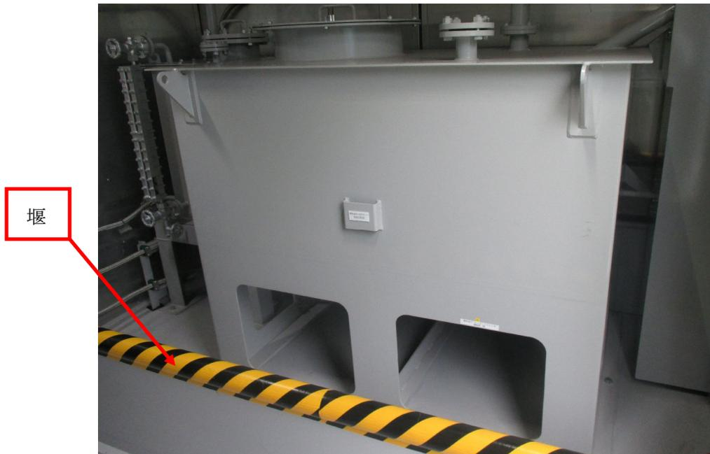
第 1 図 常設代替高圧電源装置燃料油サービスタンクの堰
