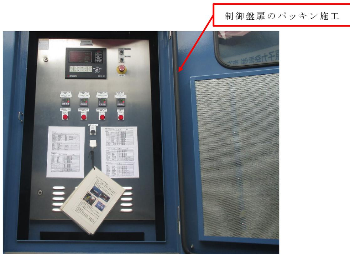
第 2 図 制御盤扉のパッキン施工
