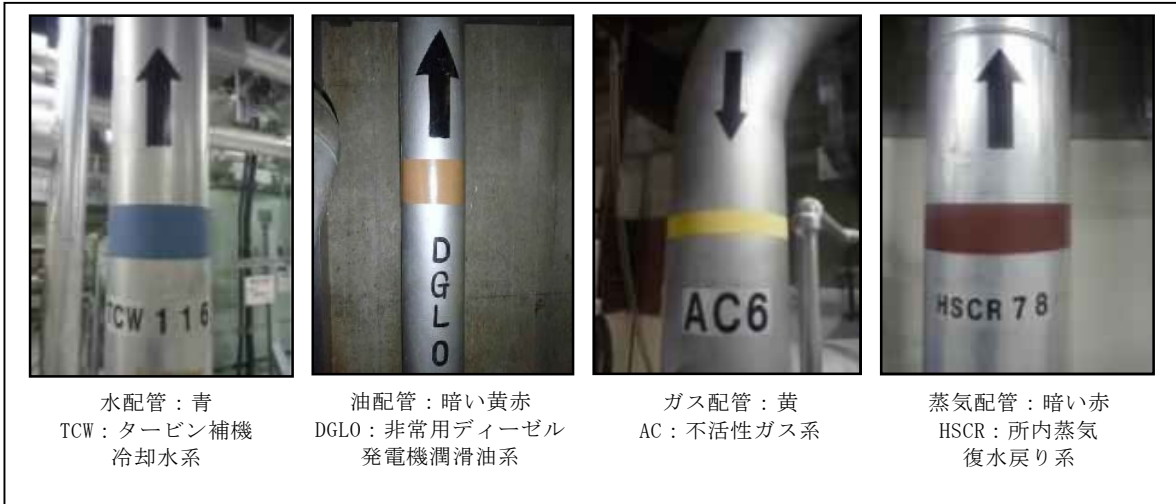
第 2.2-2 図 配管の識別管理（例）
