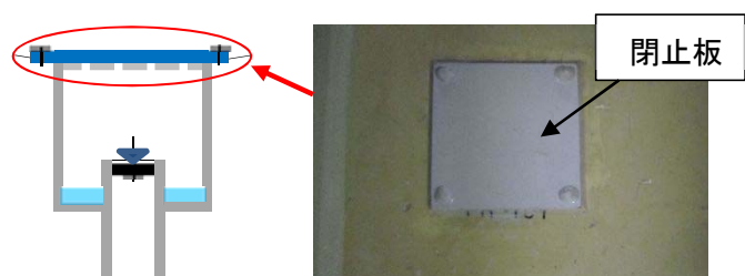
第 9.15-10 図 床ドレンファンネルの閉止例
