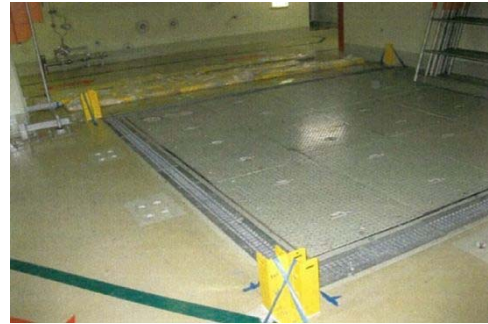
支柱レールの取付状況例
