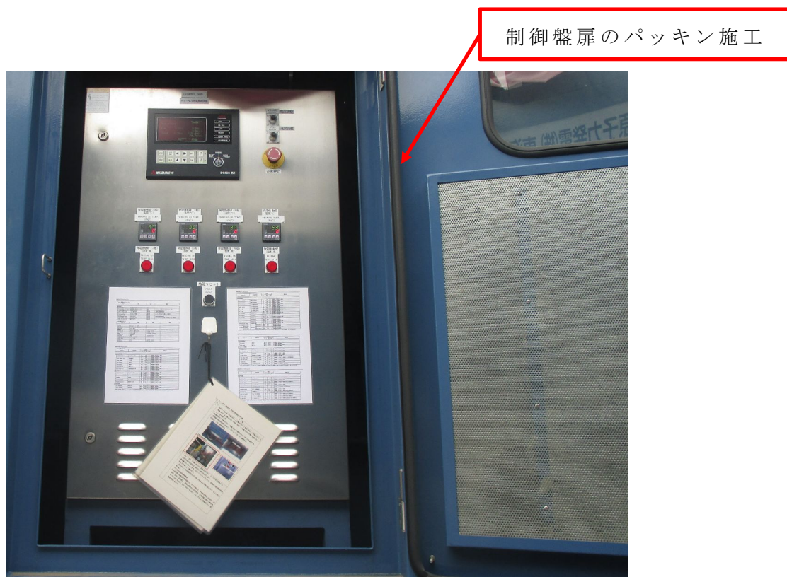
第 2 図 制御盤扉のパッキン施工
