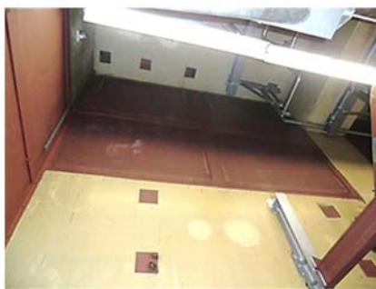
室内よりの状況 (3階 3F2)
