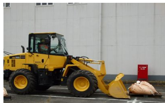
第 8-2 図 がれき撤去検証の写真
