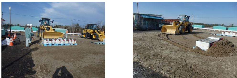
第 8-6 図 がれき撤去検証の写真
