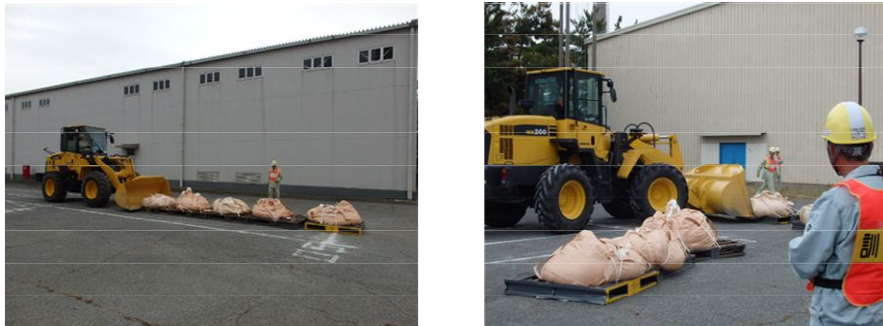
第 8-4 図 がれき撤去検証の写真
