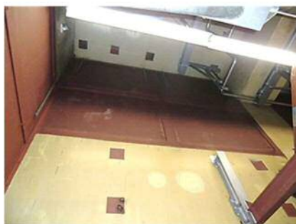
室内よりの状況 (3階 3F2)
