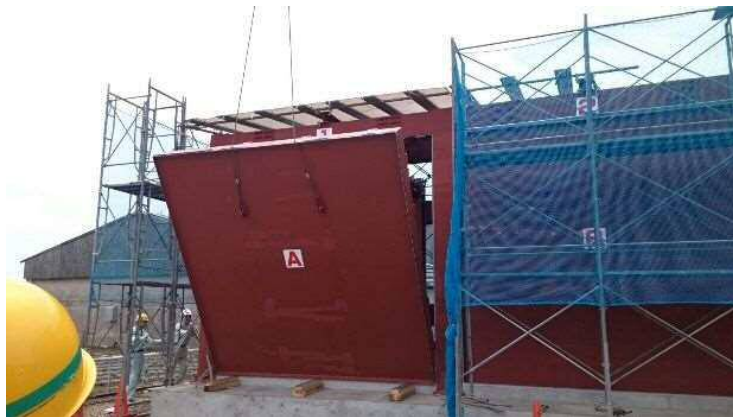
第2-14図 実機大ブローアウトパネル開放試験
