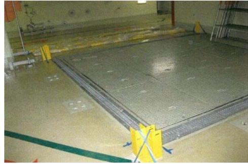
支柱レールの取付状況例
