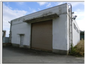
1-18 復水冷却用水路スクリーン室
