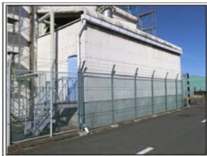
1-14 地下タンク上屋
