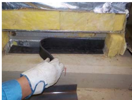
第7図 床貫通部模擬作業状況
