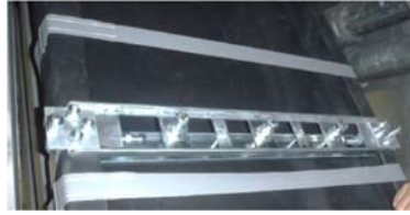
第 7-1-5 図 垂直設置方向トレイに対するファイアストップ施工例
