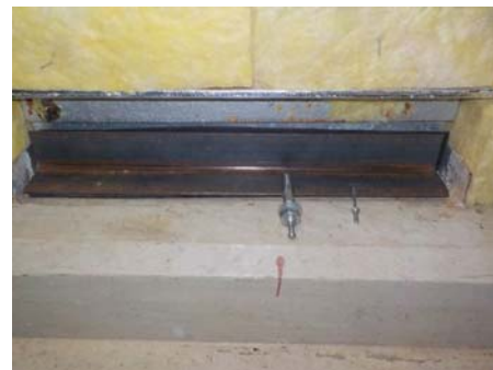
第7図 床貫通部模擬作業状況
