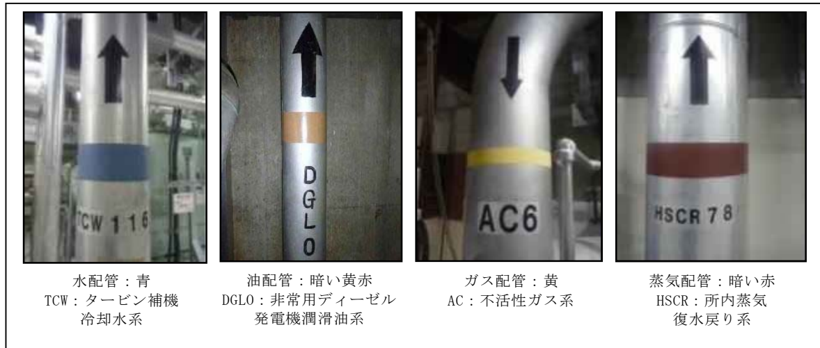
第 2. 4. 2－2 図 配管の識別管理（例）
