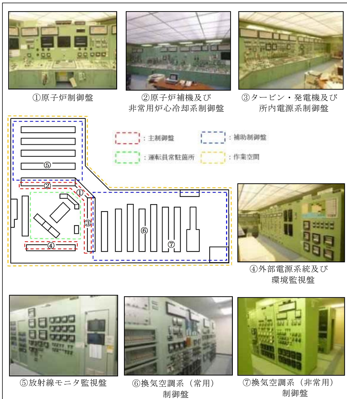
第 2. 4. 1－1 図 中央制御室の制御盤配置
