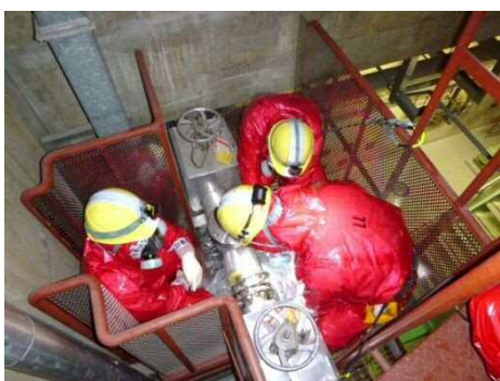
連絡配管閉止フランジ切替え訓練
