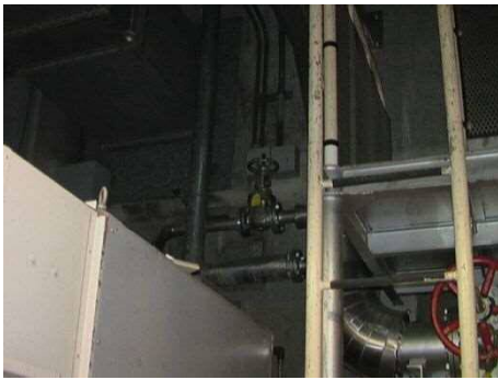
系統構成 (補助ボイラ冷却水元弁)
