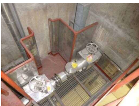
作業場所（全体）
