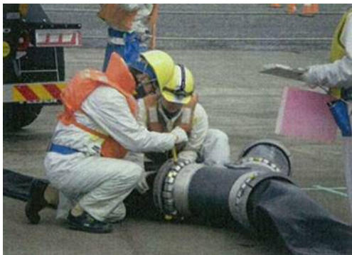
ホース接続訓練
