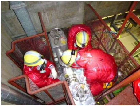
連絡配管閉止フランジ切替え訓練
