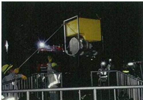
夜間での送水訓練（ポンプ設置）
