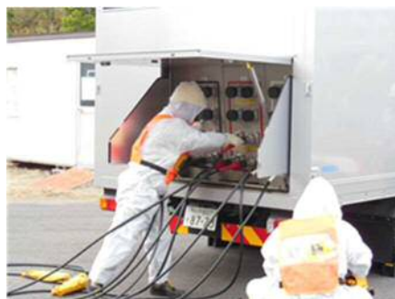
移動式高圧電源車の訓練の状況
