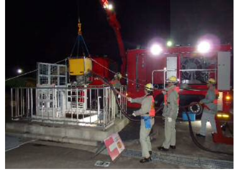
(暗所環境下での 作業状況の例)
