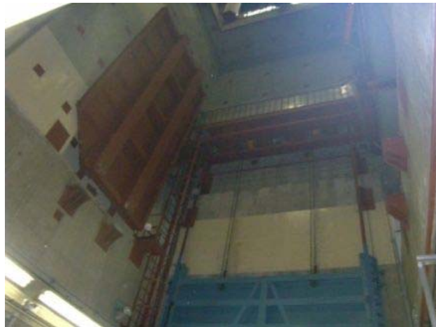
1階機器ハッチ開口状況
