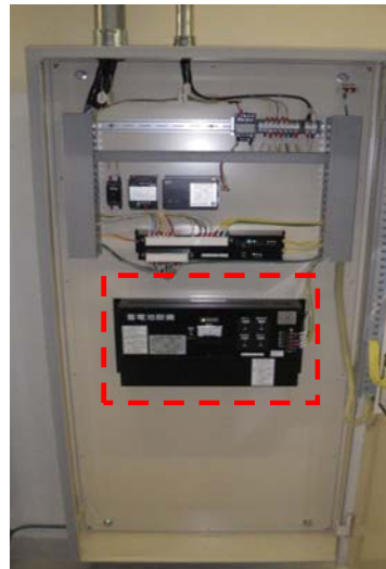
第41-1-31図 二酸化炭素自動消火設備（全域）制御盤内蓄電池
