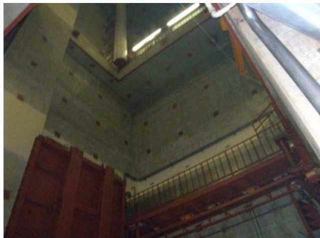
2階から3階機器ハッチ開口状況
