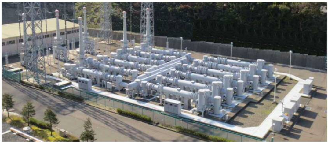
(ガス絶縁開閉装置イメージ図)
