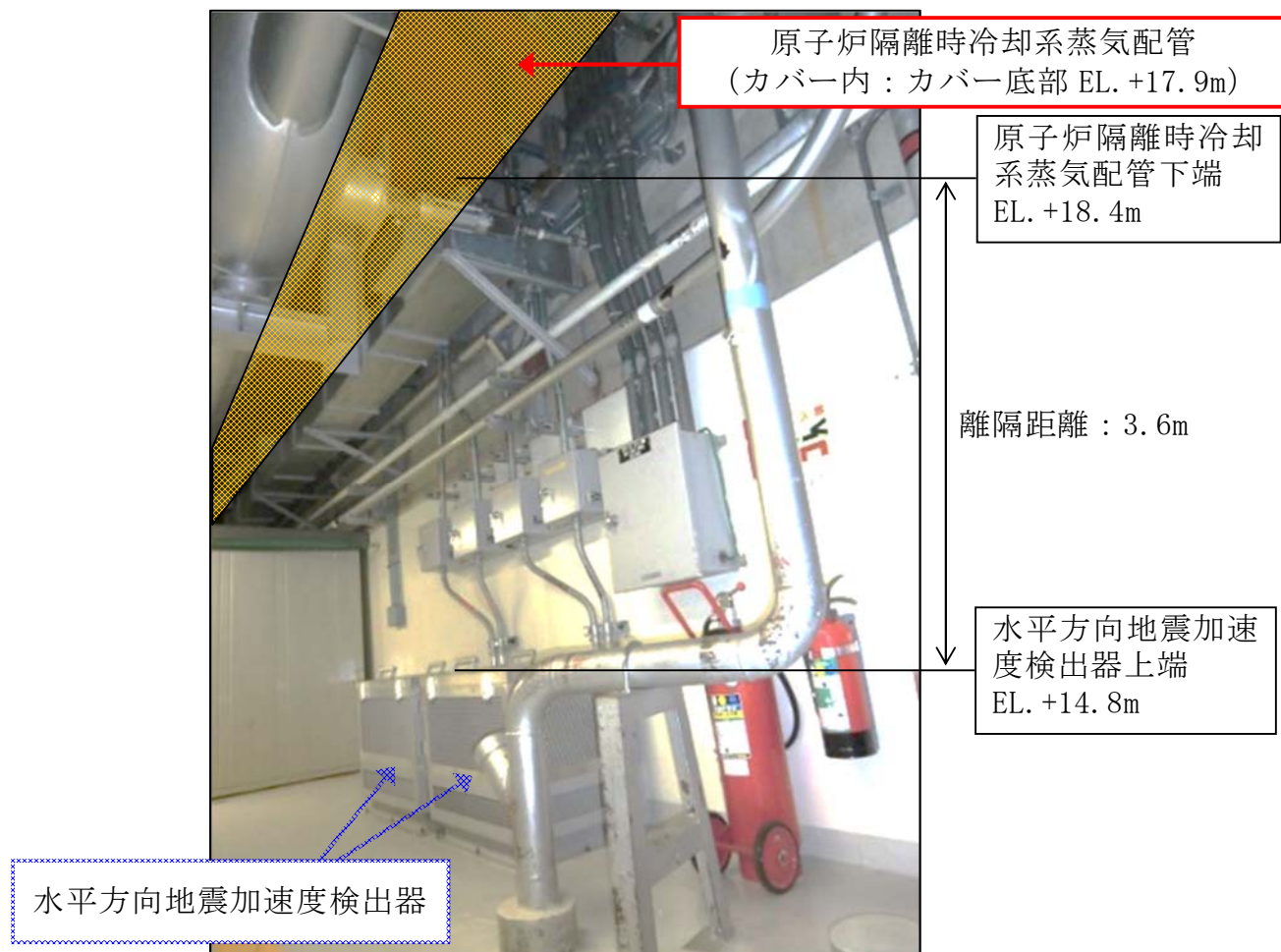
第3図 現場状況写真 原子炉棟 2階 (EL. +14.0m)
