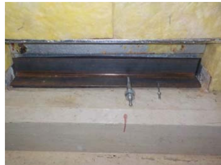
第7図 床貫通部模擬作業状況
