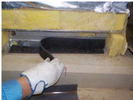
第7図 床貫通部模擬作業状況
