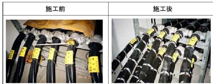
(2) 受け枕、ラック等へのケーブルの結束はケーブル敷設工事基準に従ってください。
