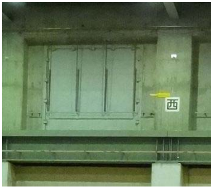
別図 1－32 発電所における原子炉建屋原子炉棟外壁の 原子炉建屋外側ブローアウトパネルの設置状況
