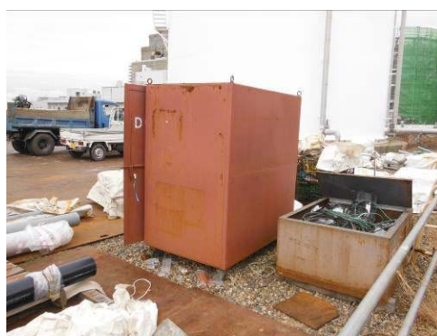
#62 鋼製ボックス
