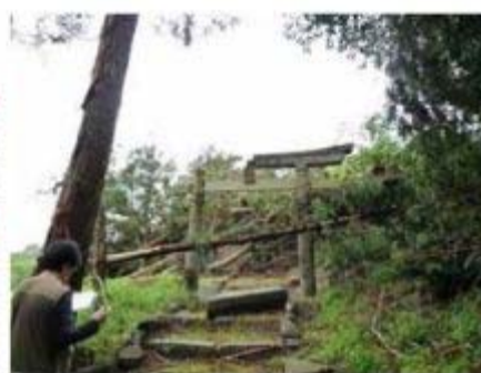
樹木の折損と鳥居の被害
