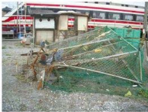
フェンスの著しい変形
