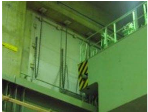
別図 1－32 発電所における原子炉建屋原子炉棟外壁の 原子炉建屋外側ブローアウトパネルの設置状況
