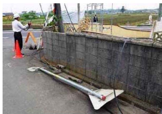
道路標識の倒壊
