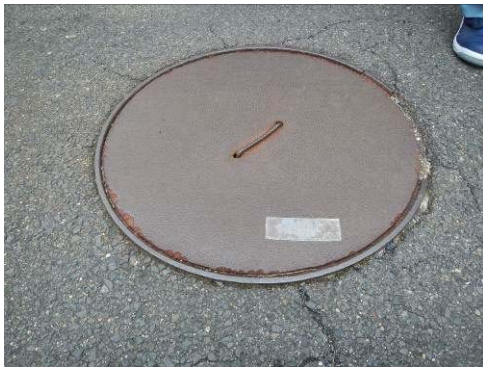
#316 マンホール蓋
