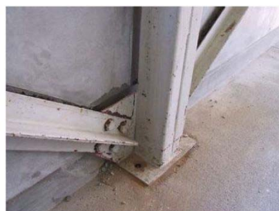
間柱脚部アンカーボルト破断
