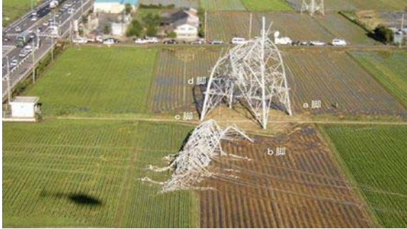
強風による鉄塔の倒壊事例①※ 1
