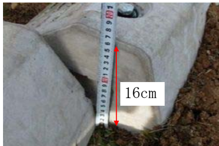
【段差復旧検証用段差】
