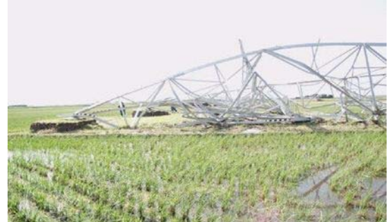
強風による鉄塔の倒壊事例②※ 1
