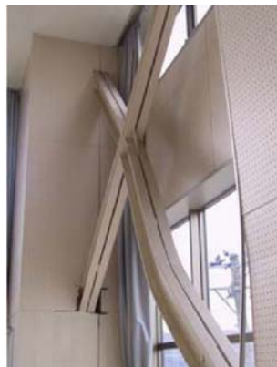
間柱脚部アンカーボルト破断
