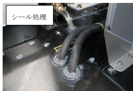
第1図 可搬型設備 小動物対策例 (1/2)
