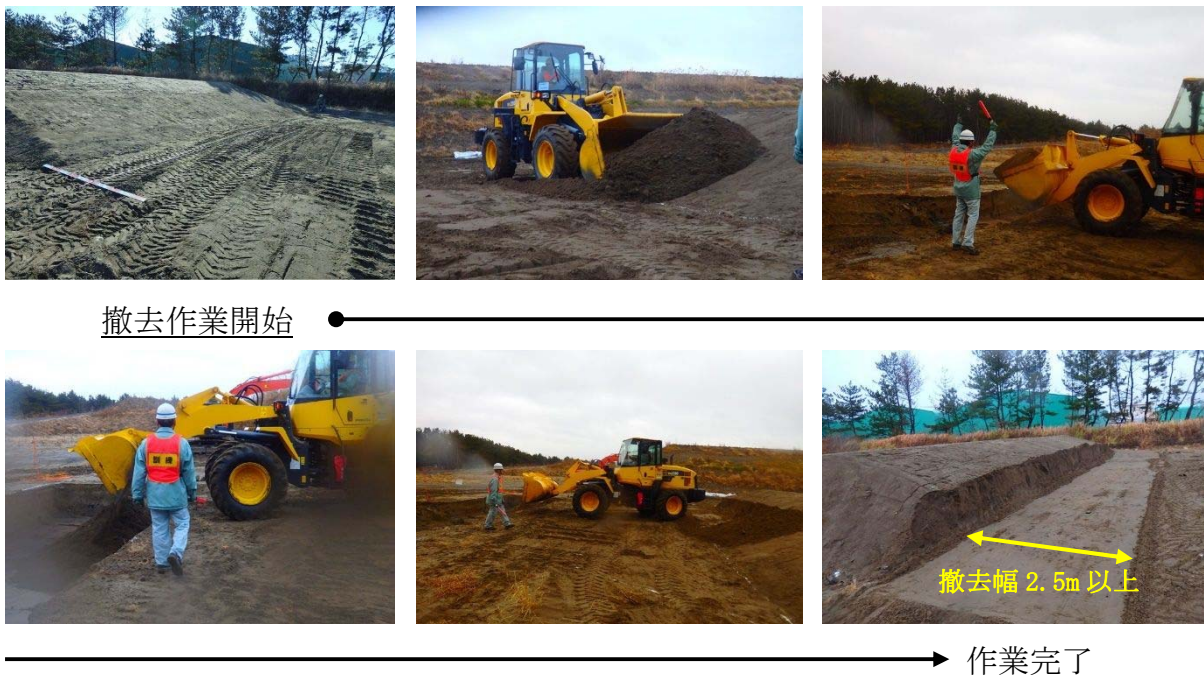
第 8 図 土砂撤去検証の写真
