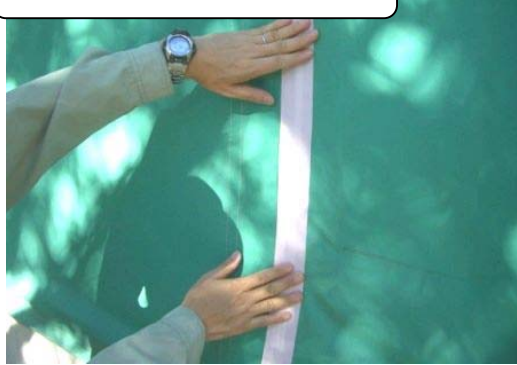
④ 難燃テープによるシール
