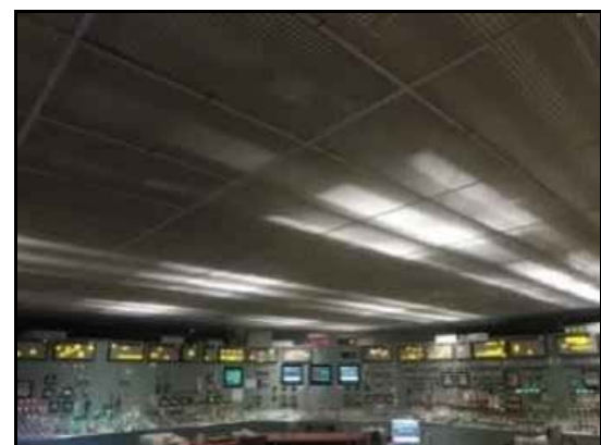
(直流非常灯点灯状態)
