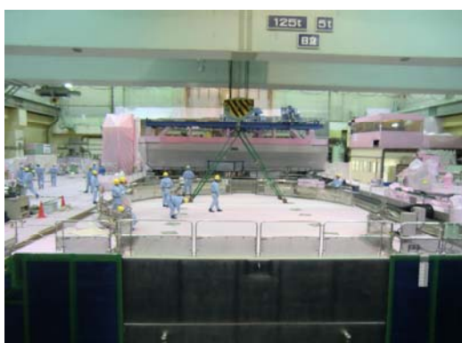
使用済燃料プール周り（全体）
