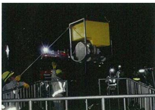
可搬型代替注水大型ポンプ
