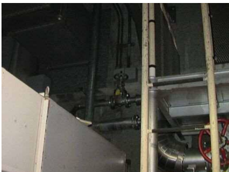
系統構成 (補助ボイラ冷却水元弁)
