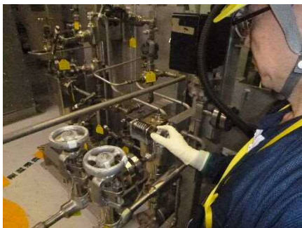
ポンプメカシールパージ流量調整操作 （原子炉冷却材浄化系ポンプメカシールパージ水ライン調整弁）
