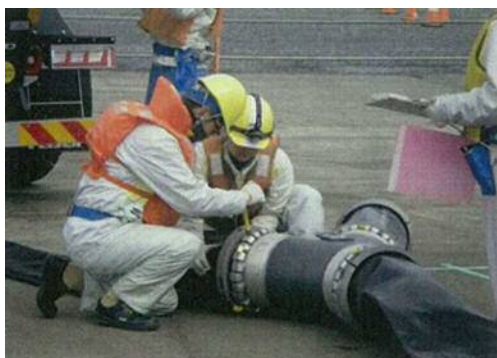
ホース接続訓練
