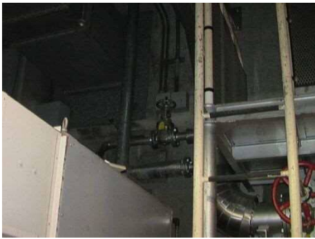
系統構成 (補助ボイラ冷却水元弁)
