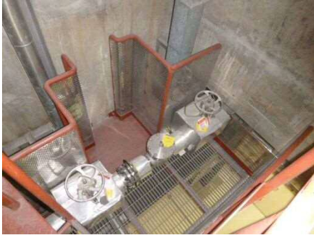
作業場所（全体）
