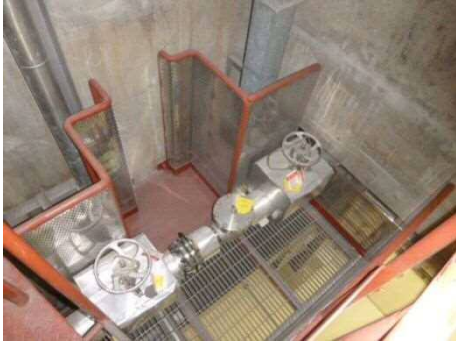
作業場所（全体）
