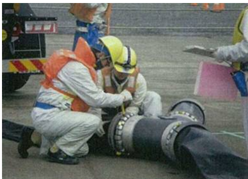
ホース接続訓練
