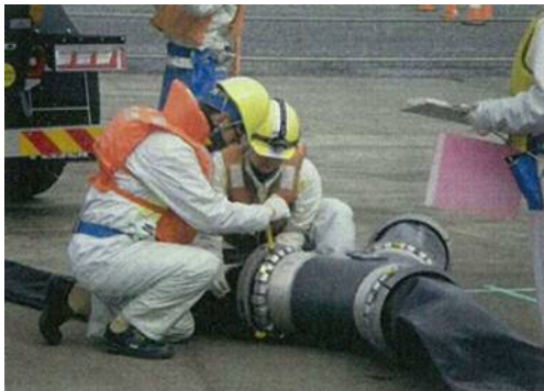
ホース接続訓練
