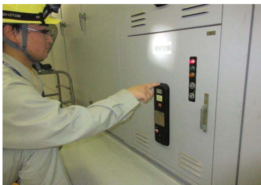
不要負荷切離し（遮断器）
