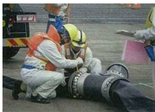
ホース接続訓練
