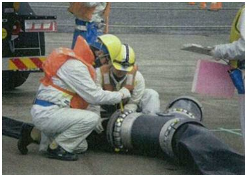
ホース接続訓練
