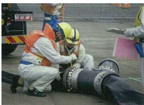
ホース接続訓練
