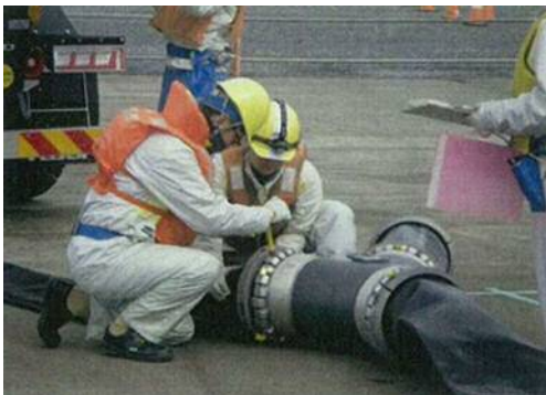
ホース接続訓練
