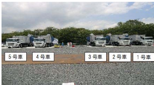
常設代替高圧電源装置（イメージ）
