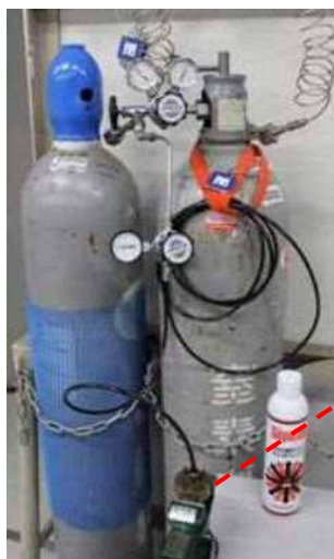
図5 気密確認試験状況
