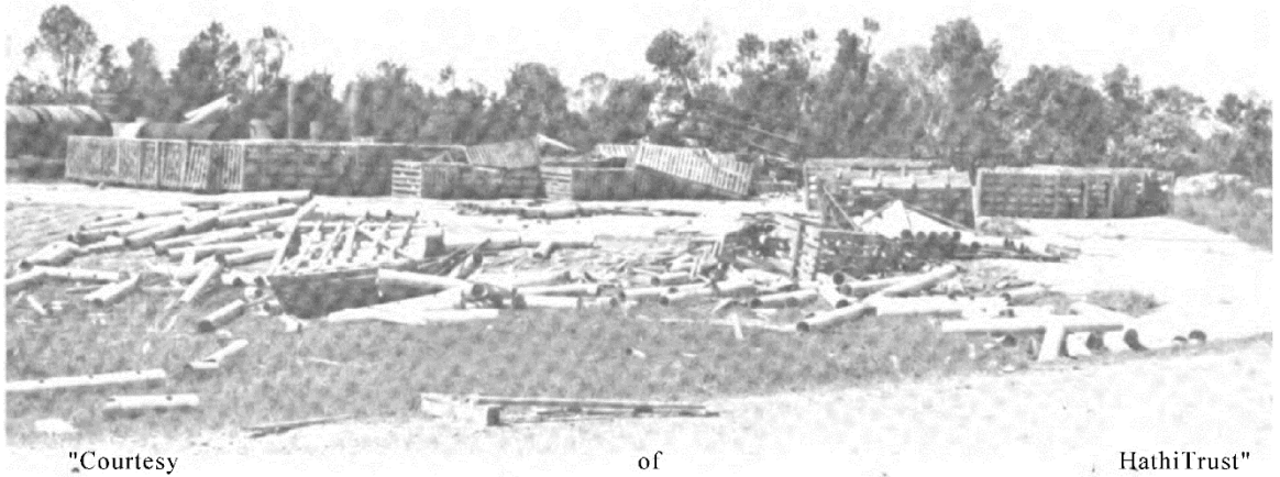
図5-1 Grand Gulf原子力発電所の資材置場におけるパイプの散乱状況 (10)
