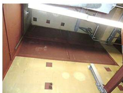
室内よりの状況 (3階 3F2)
