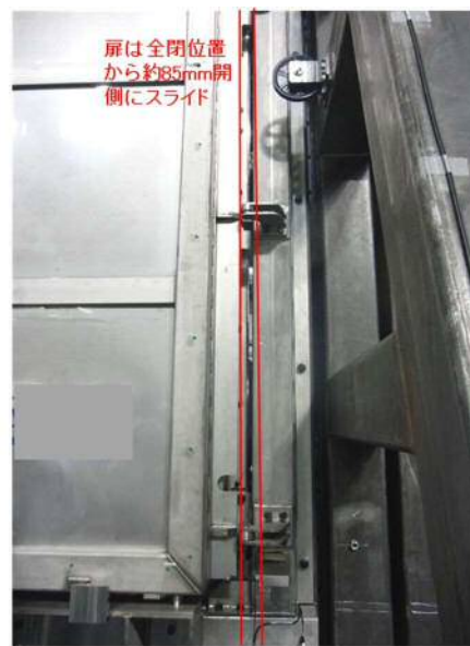
扉閉レベル4(1.1Ss)後の扉状態(6月21日)
