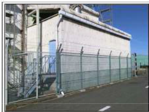
1-14 地下タンク上屋
