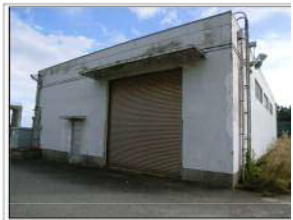
1-18 復水冷却水路スクリーン室
