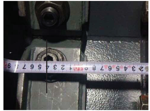
図 5. 13. 1－19 ゴムジョイント設置時 枠－ボルト間計測
