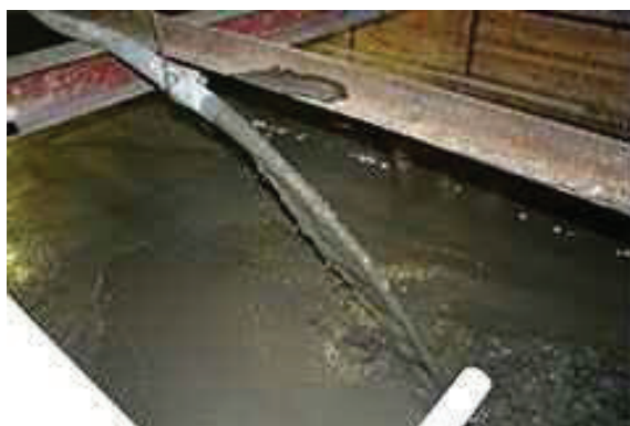
図 5.14.6-7 流動化処理土打設状況
