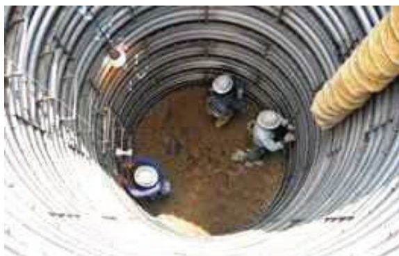
図 5.14.6-3 ライナープレート施工状況
