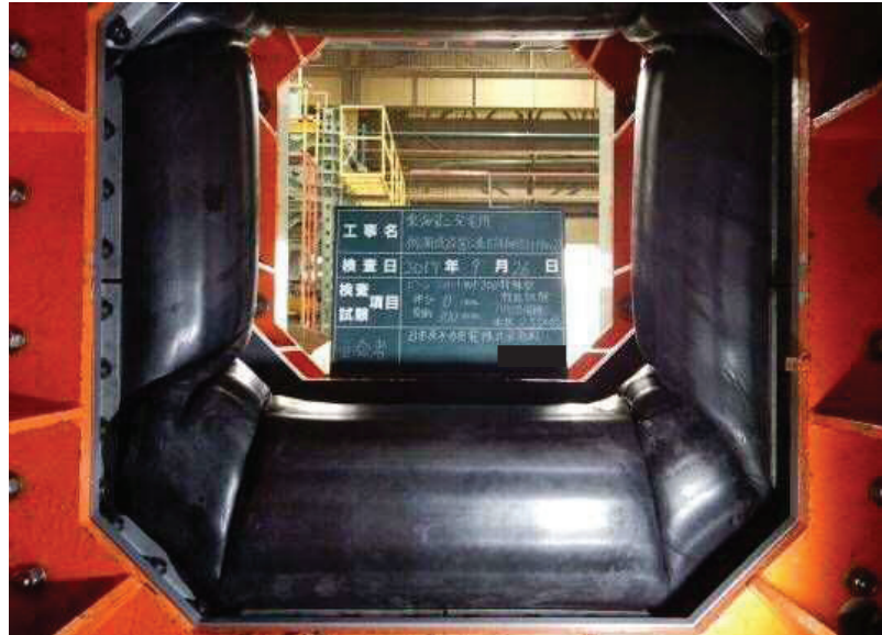
底版・側壁（漏えいなし）
