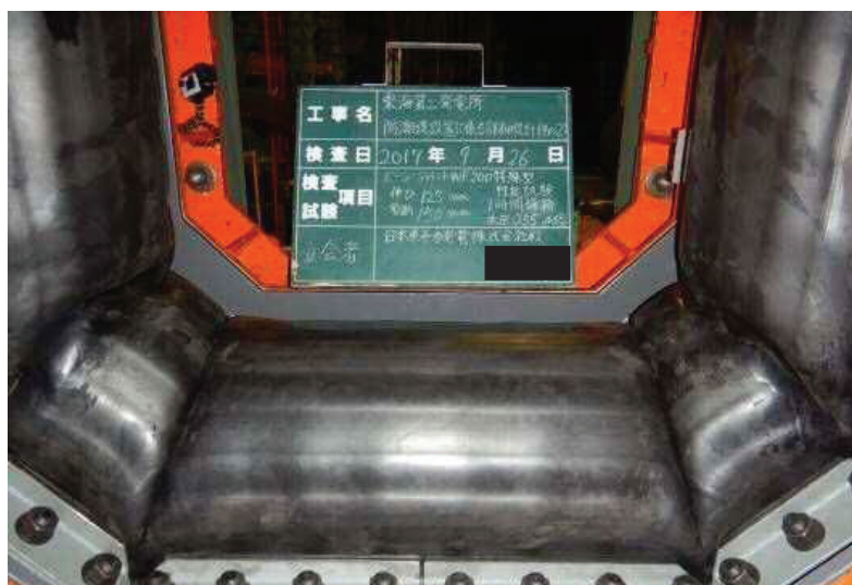
底版・側壁（漏えいなし）
