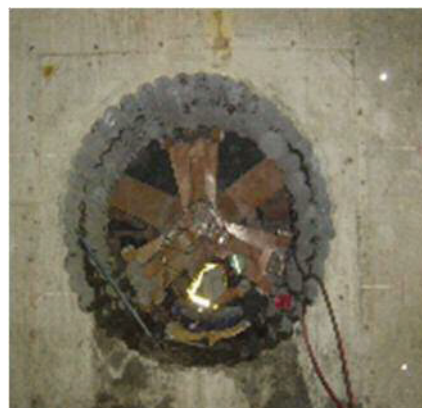
図 5.14.5-4 連続コアによる削孔
