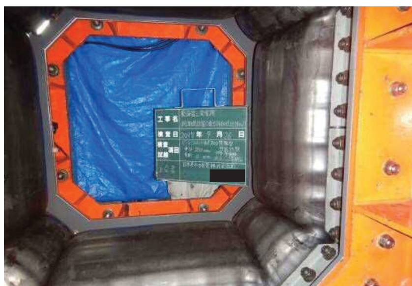
側壁 (漏えいなし)
