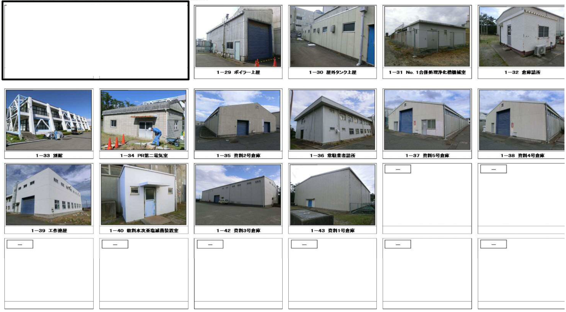
図4.3.2.4-4 鉄筋コンクリート造建物・構築物
