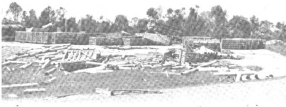
パイプを収納した木箱（一部 2 段重ね）は浮上せずに転倒し、パイプが周囲 7m~9m に散乱
