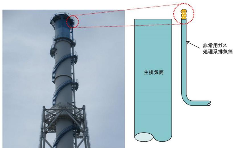
図 1-10 非常用ガス処理系排気筒
