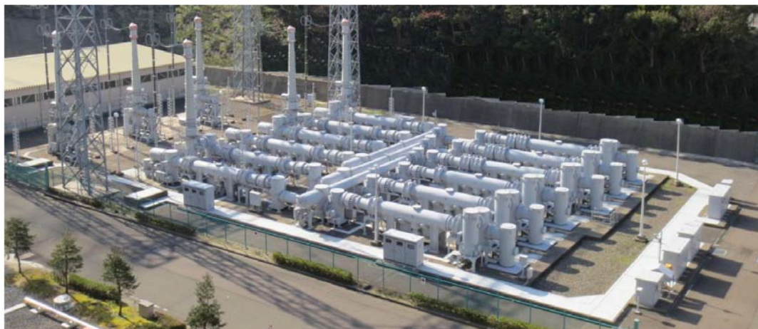
(ガス絶縁開閉装置イメージ図)
