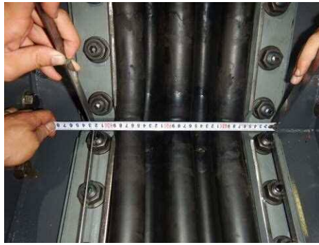
ボルトピッチ計測状況
