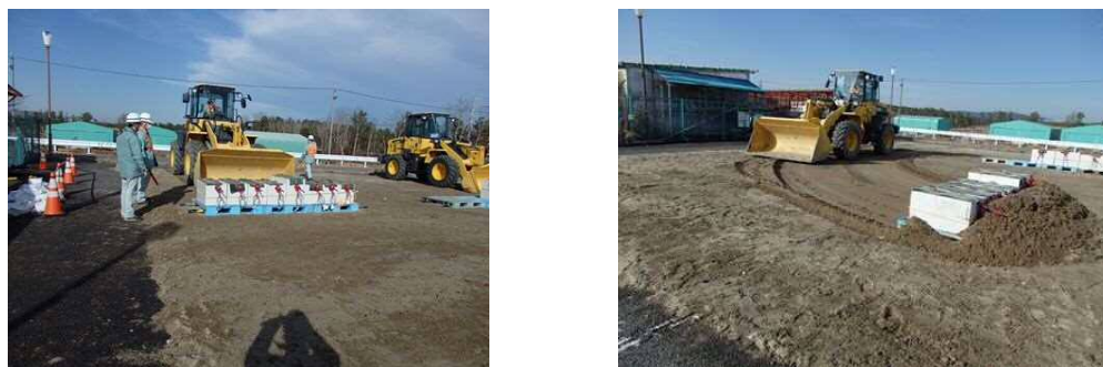
第 8-6 図 がれき撤去検証の写真
