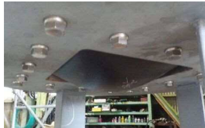
漏水試験時の状況 (0.17MPa10分後)
