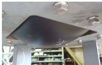
漏水試験時の状況 (0.21MPa10分後)
