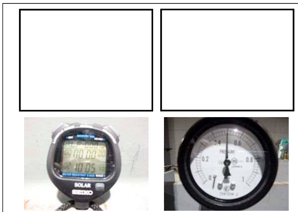
図 5.13.2.2-19 0.50 MPa 10 分経過後(漏えい無し)
