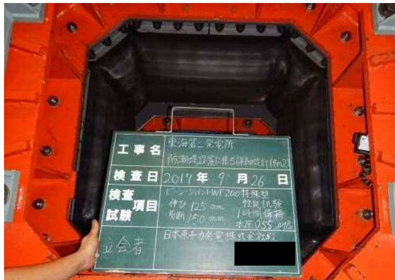
頂版 (漏えいなし)
