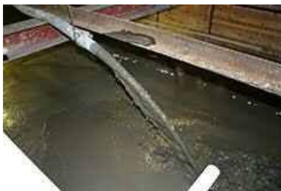
図 5.14.6-7 流動化処理土打設状況
