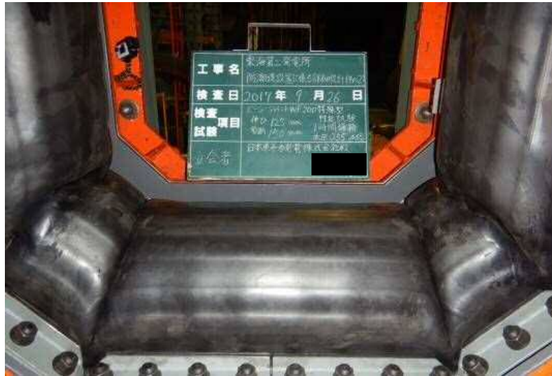
底版・側壁（漏えいなし）
