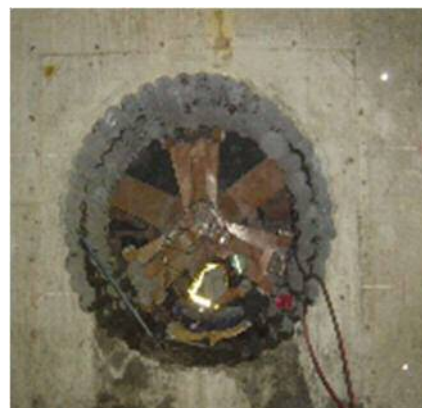
図 5.14.5-4 連続コアによる削孔
