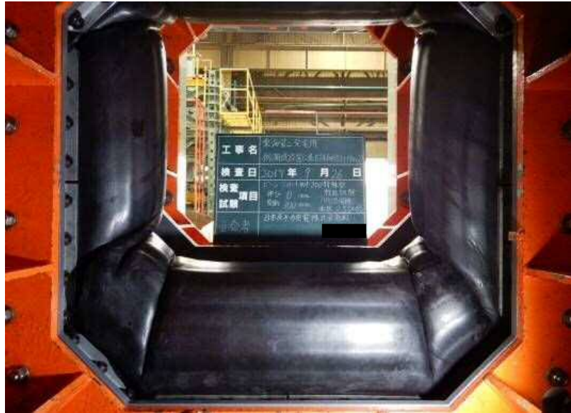
底版・側壁（漏えいなし）
