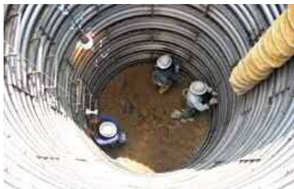
図 5.14.6-3 ライナープレート施工状況
