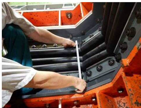
ボルトピッチ計測状況
