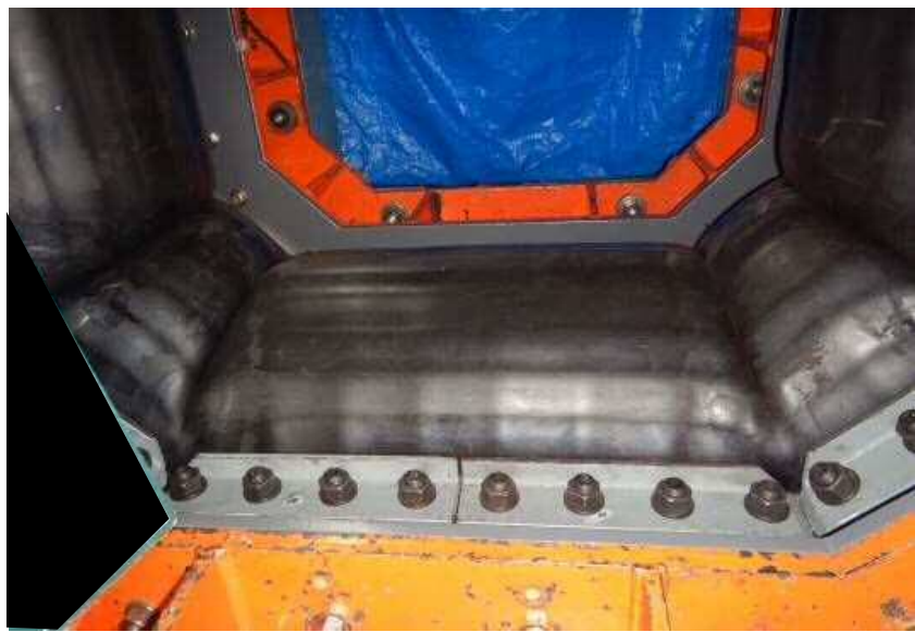
底版 (漏えいなし)
