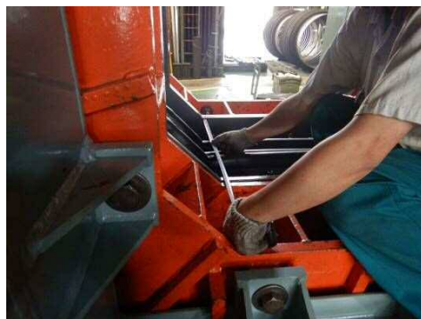
桁間距離計測状況
