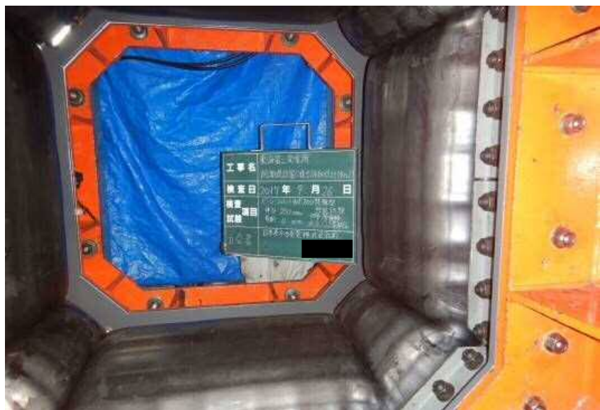
側壁 (漏えいなし)
