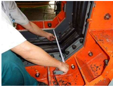
桁間距離計測状況
