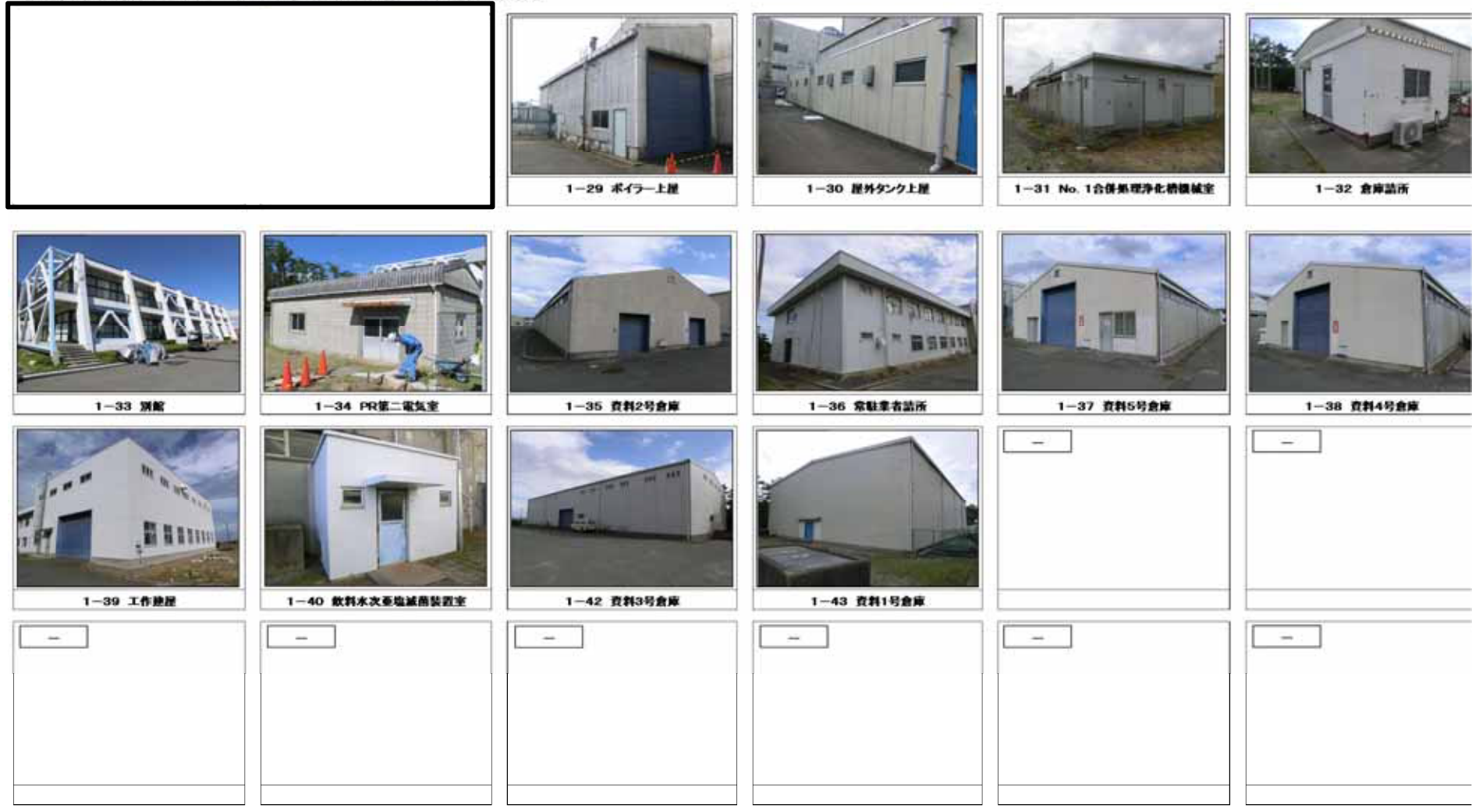
図4.3.2.4-4 鉄筋コンクリート造建物・構築物
