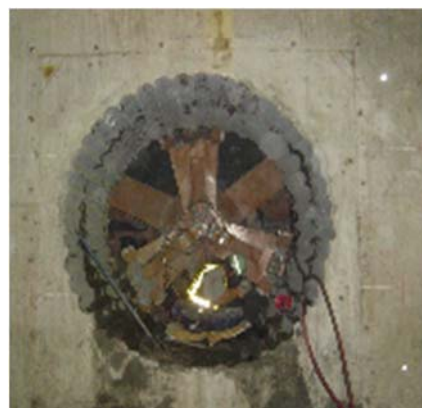
図 5.14.5-4 連続コアによる削孔
