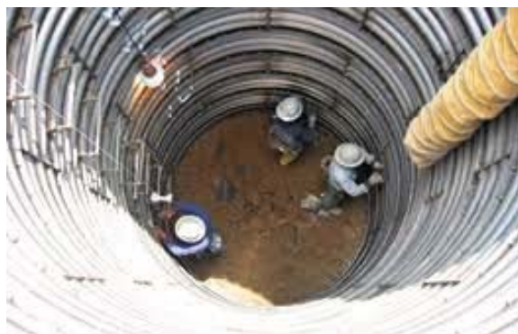
図 5.14.6-3 ライナープレート施工状況
