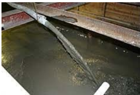
図 5.14.6-7 流動化処理土打設状況
