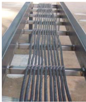
(シート施工前)
