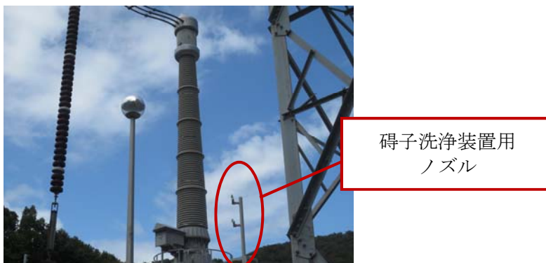
図 17 碍子洗浄装置外観（イメージ）
